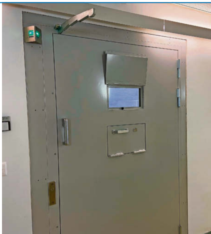
Die Tür zum Isolationszimmer wiegt 300 Kilogramm und ist elektronisch gesichert.
